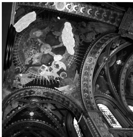
Rys. 7. Uszkodzenia tynków i polichromii kopuły na skrzyżowaniu nawy głównej i transeptu
