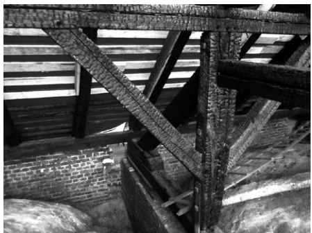
Rys. 6. Uszkodzenia wybranych elementów więźby
