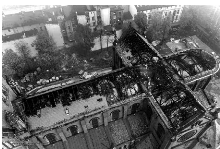
Rys. 5. Pozostałości po wypalonej drewnianej więźbie (fot. F. Rozmus)
