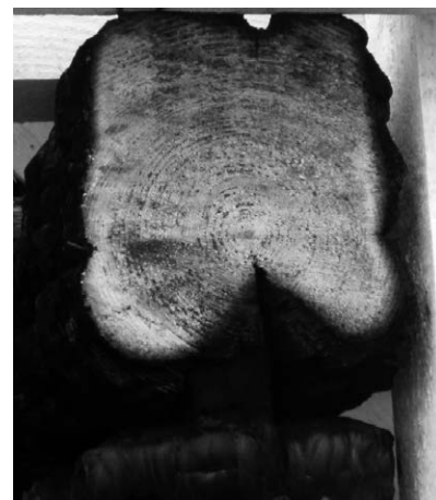
Rys. 8. Uszkodzenia przekroju górnej płaty
